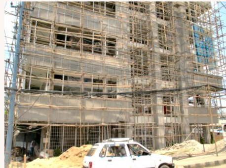
Bauweise mit Bambusfeilern
